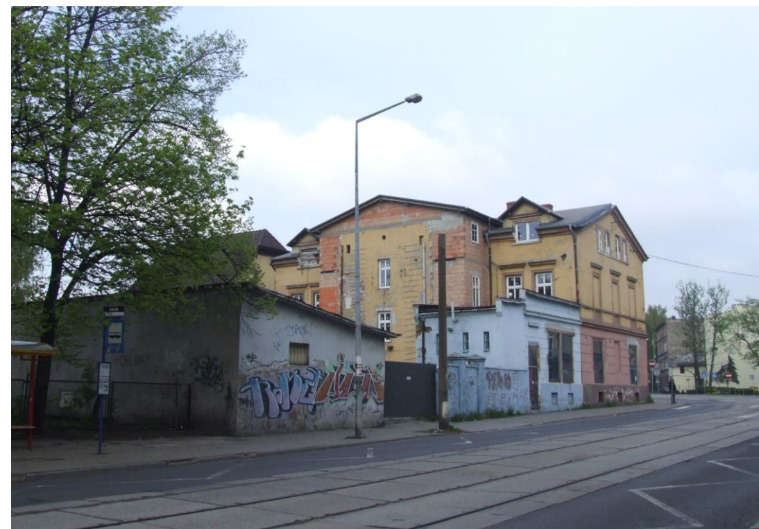
STAN PRZED PRZEBUDOWĄ
